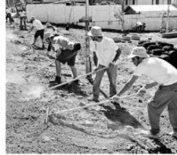
Voluntariado conjunto de Alstom Chile, Fundación Mi Parque y vecinos rastrellando la tierra para más tarde instalar el pasto que transformará el lugar en un parque.
